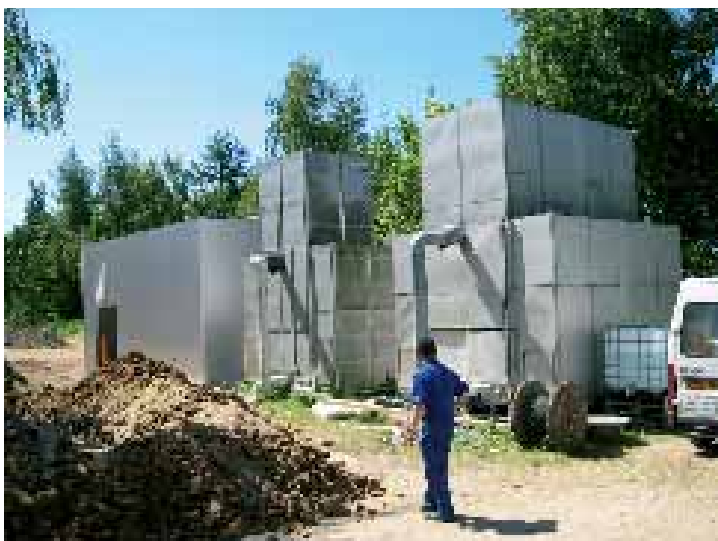
Absorptionskøleanlægget på Chr. Hansen A/S under etablering (tv). Køletårnene ses til højre i billedet.
