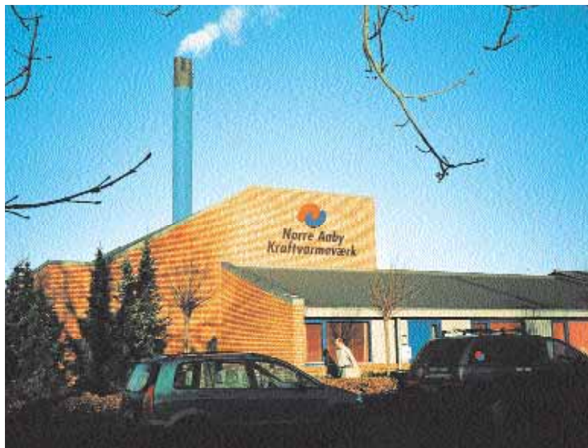
Nørre Aaby Varmeværk har fået nyt moderne SRO-anlæg - i tre etaper.
