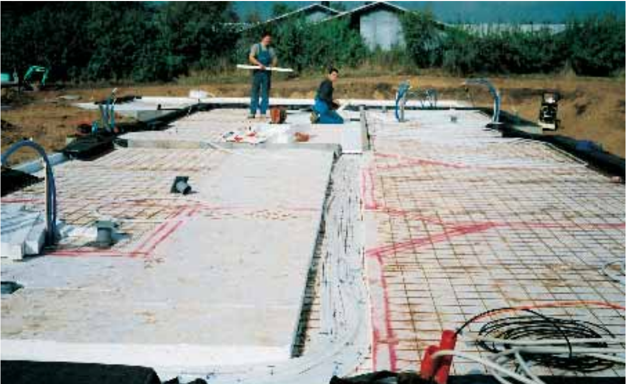
Udlægning af gulvvarmeslanger "som viplejer" på Savværksvej 66 i Rødokro. Det fremgår med al ønskelig tydelighed af billedet, hvor ledestingene ikke bør laves.
