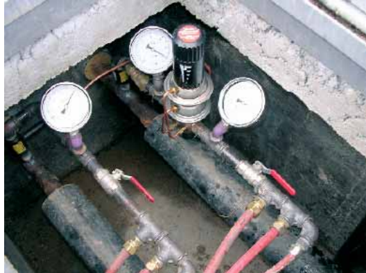
En differensstrykregulator sørger for, at trykket svarer til niveauet ude hos den yderste forbruger.
