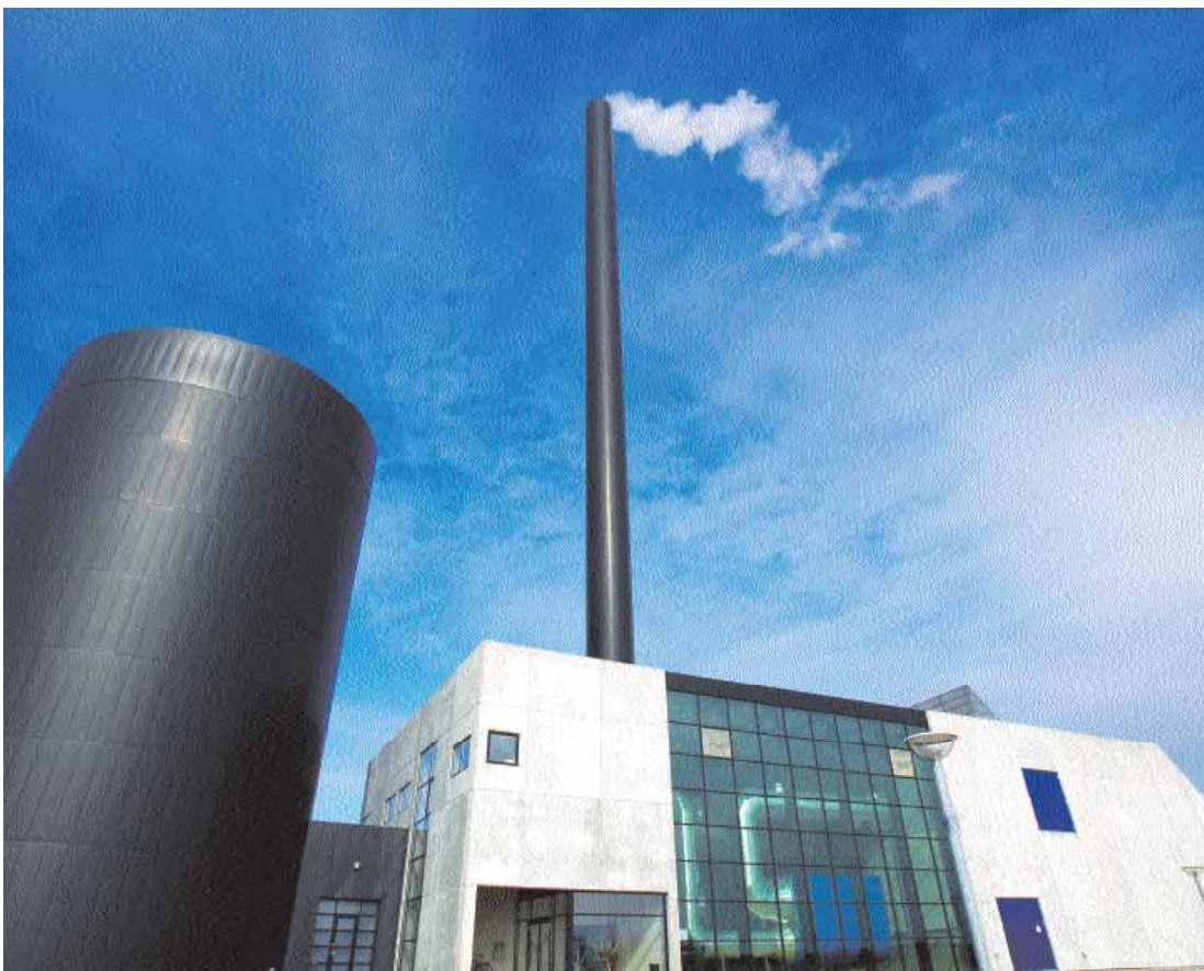
Skagen Varmeværk har indgået en toårig aftale med DONG om at få leveret varme til en fast pris.
