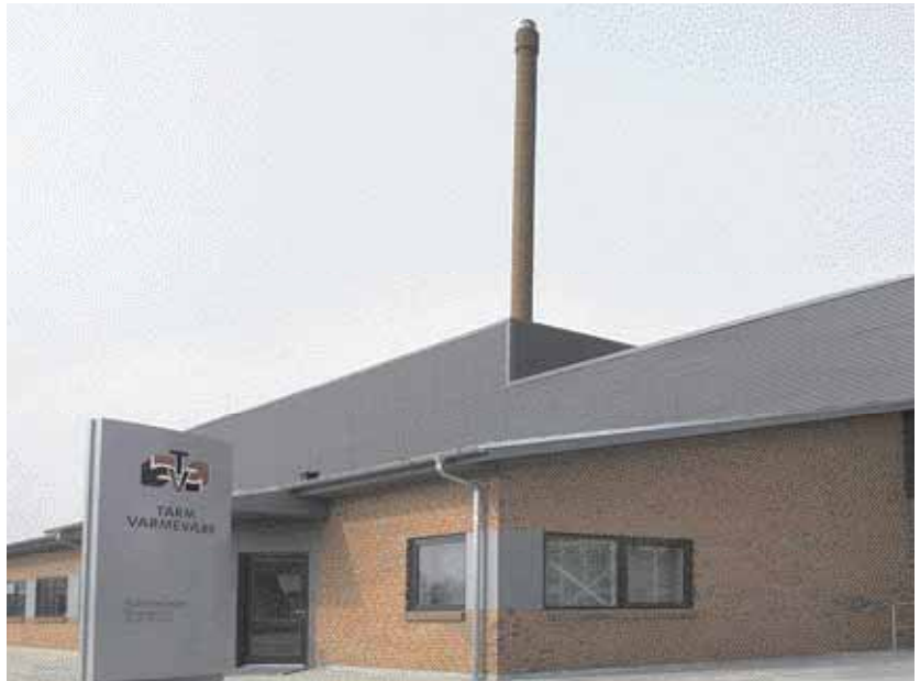
Tarm Varmeværk er blandt fire fjernvarmeværker, der i det sidste års tid har arbejdet med at få deres fjernvarmevand miljødeklareret.
