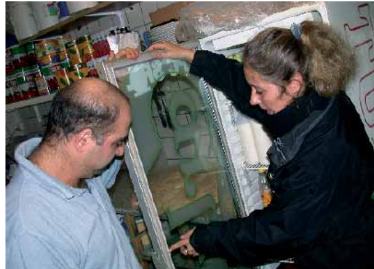
Pia Rasmussen og hendes kolleger fra Frederiksberg Forsyning konstaterede på besøgene hos byens indvandrerboutikker, at dårligt isolerede kølemøbler er en typisk energisluger. Foto: Frederiksberg Forsyning.
