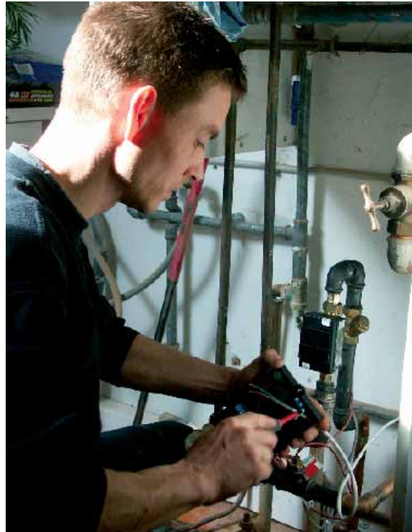
Jacob Knudsen fra firmaet Gert Nielsen arbejder med at tilslutte den nye, digitale måler i en bolig på Dragebakken i Odense. Mange flere huse venter, for Odense Kommunale Fjernvarme er i færd med et omfattende projekt, hvor alle 54.000 målere udskiftes.
