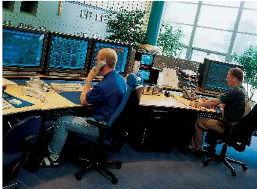
I Frederiksberg Forsynings kontrolrum overvåges driften døgnet rundt af minimum en vagthavende.
