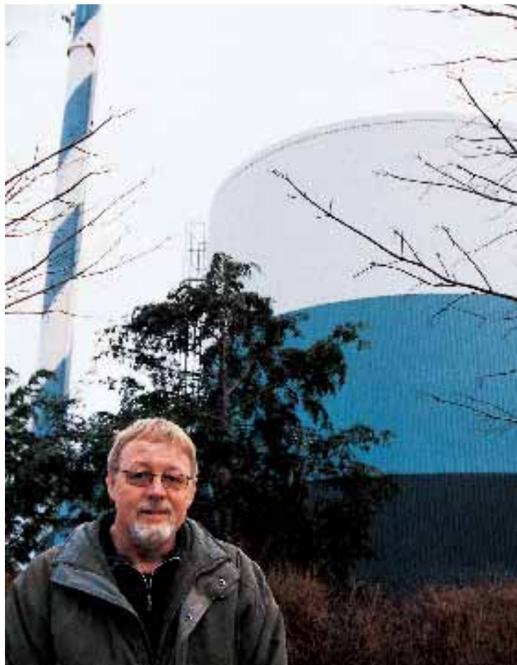
Haarby Kraft-Varme, hvor Gert Petersens er driftsleder, kan spare mellem 150.000 og 200.000 kr. hvis de får en større akkumuleringstank. I stedet for at købe en ny, forhøjes den nuværende med fire meter. Det svarer cirka til en stribe mere.
