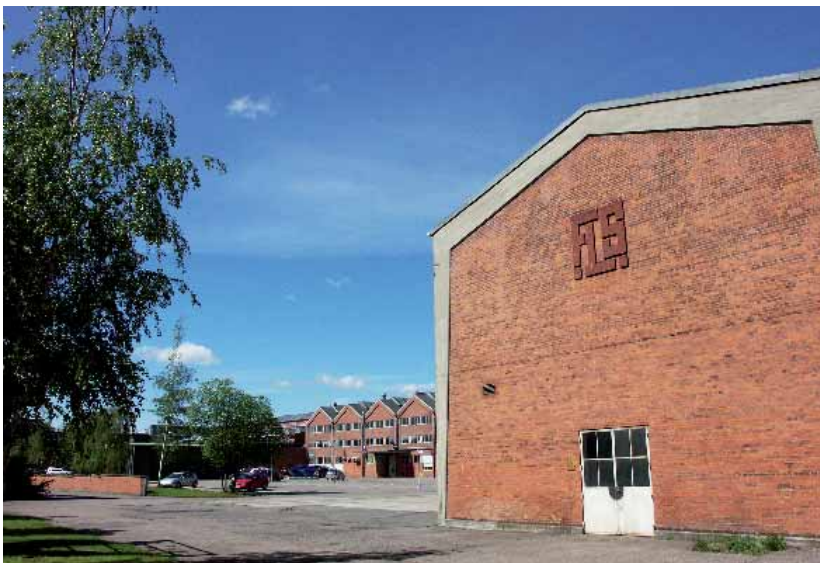
De gamle fabriksbygninger på FL Schmidts grund i Valby udgør bare en lille del af det kæmpe areal, der bliver en helt ny bydel i Valby. Det hele skal fjernvarmeforsynes, og det er en krævende opgave for Københavns Energi. Foto: Flemming Rasmussen.
