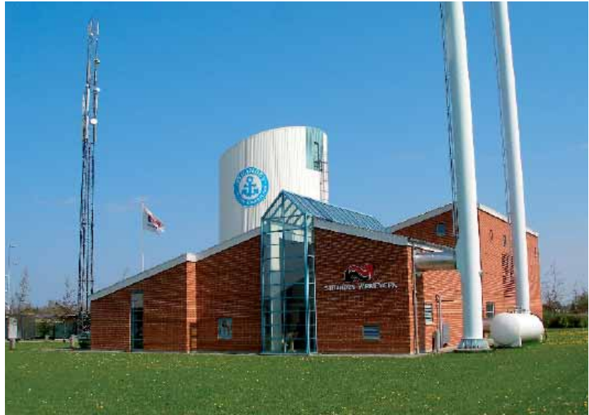
Etableringen af et 8.000 m 2 stort solvarmeanlæg åbner flere muligheder for Strandby Varmeværk. En af dem er at levere køling til de mange virksomheder på havnen. Foto: Viktor Jensen.
