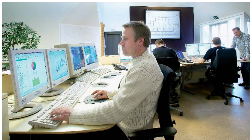
Den nye hovedcentral var anledningen til at ombygge og modernisere den 15 år gamle driftscentral. Foto: Claus Peuckert Fotografi.
