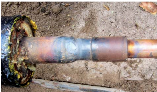
Foto 1: Aqua-varm rør uden tegn på udvendig korrosion.
