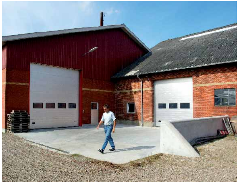
Varmemester Jens Larsen (billedet) og hans medarbejder, Kaj Andersen, kan glæde sig over, at luften i halmopriverrummet er blevet renere, efter at der er installeret en tæt kasse omkring et nedskubber stempel ved halmopriverrummet.
