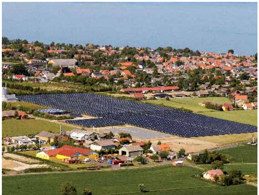
Verdens største solfangeranlæg på 19.000 m 2 er tilknyttet Marstal Fjernvarme, der har anvendt solvarme i kombination med fjernvarme i mere end 10 år.
