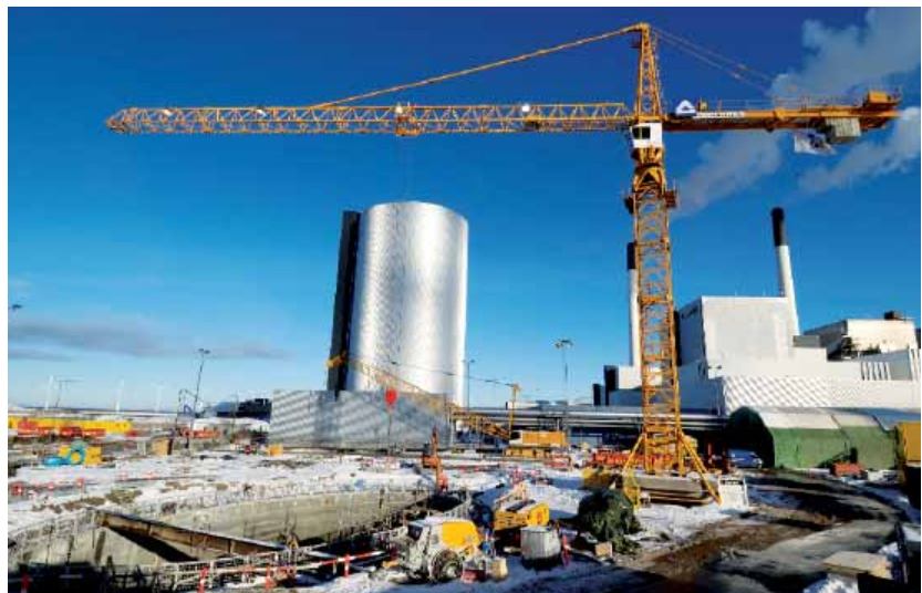
Den første af de tre skakter ned til tunnelen etableres ved Amagerværket, hvor den 300 grader varme fjernvarmedamp produceres. Arbejdet med denne skakt er langt fremme og det er her, boremaskinen starter sit arbejde. Foto: Henrik Pyndt Sørensen.
