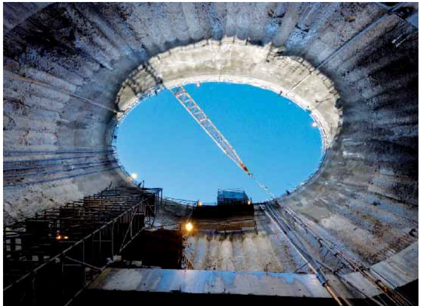
Tunnelen skal ligge mellem 20 og 40 meter under jorden, hvilket er lige under en kommende Metrocityring. Her er det udsigten mod himlen fra bunden af skakten ved Amagerværket. Foto: Henrik Pyndt Sørensen.
