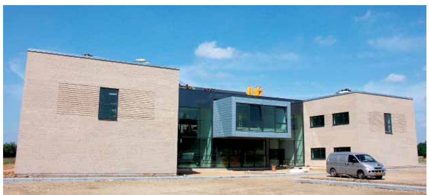
1. september var selv belægningen på parkeringspladsen lagt ud. På det tidspunkt var håndværkerne indvendigt i fuld gang med at få huset helt klar til indflytning i starten af oktober.
