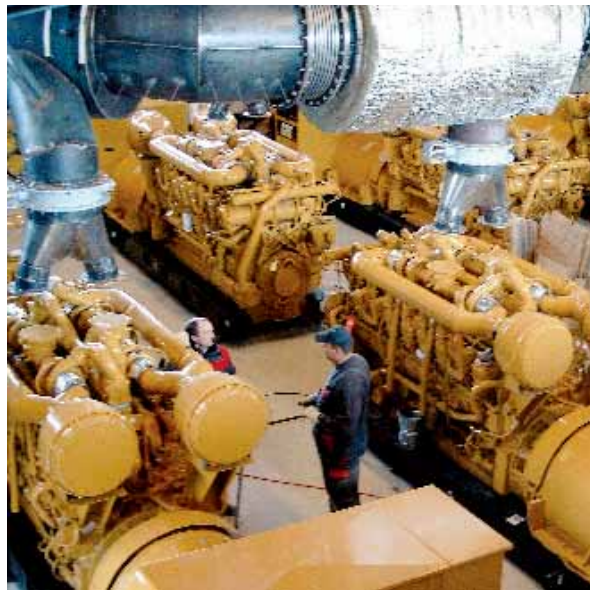
Det regulerkraftanlæg, der skal bygges i Assens, er magen til det, Energi Fyn i øjeblikket er ved at gøre klar til brug i Bellinge ved Odense. Otte dieselmotorer og en "dypkoger" sørger for, at anlægget både kan tilbyde op- og nedregulering.
