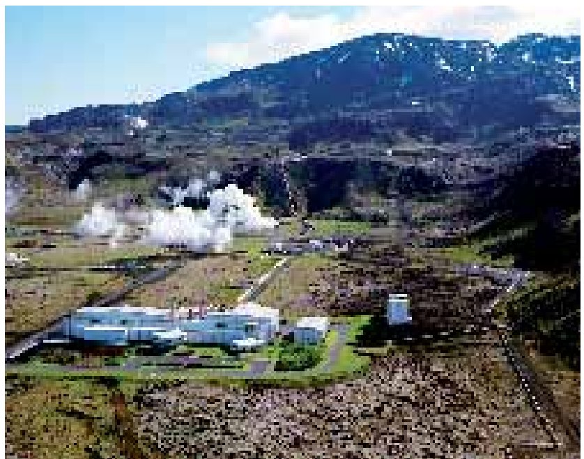
Med sin beliggenhed i Hengill Bjergene, er Nesjavellir et af verdens smukkeste placerede kraftvarmeværker. Foto: ABB.
