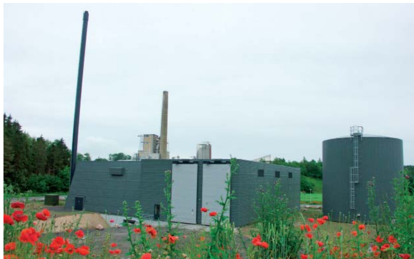
Faxe Fjernvarmeselskabs nye flisværk ligger tæt ved Faxe Kalk, der i årevis har leveret varme til fjernvarmenettet. Kalkbrænderiet ses i baggrunden. Det nye værk kan således koble sig på den eksisterende transmissionsledning ind til byen. Foto: Flemming Rasmussen.
