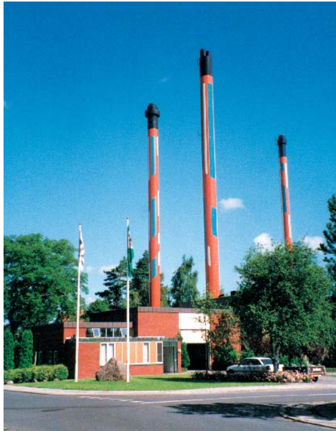
Otterup Kommunale Fjernvarme har knap 2.000 forbrugere. Værkets priser er blandt landets laveste og ifølge driftsleder Kaj Johansen er både anlæg og ledningsnet i meget fin stand. Foto: Lone Völcker.
