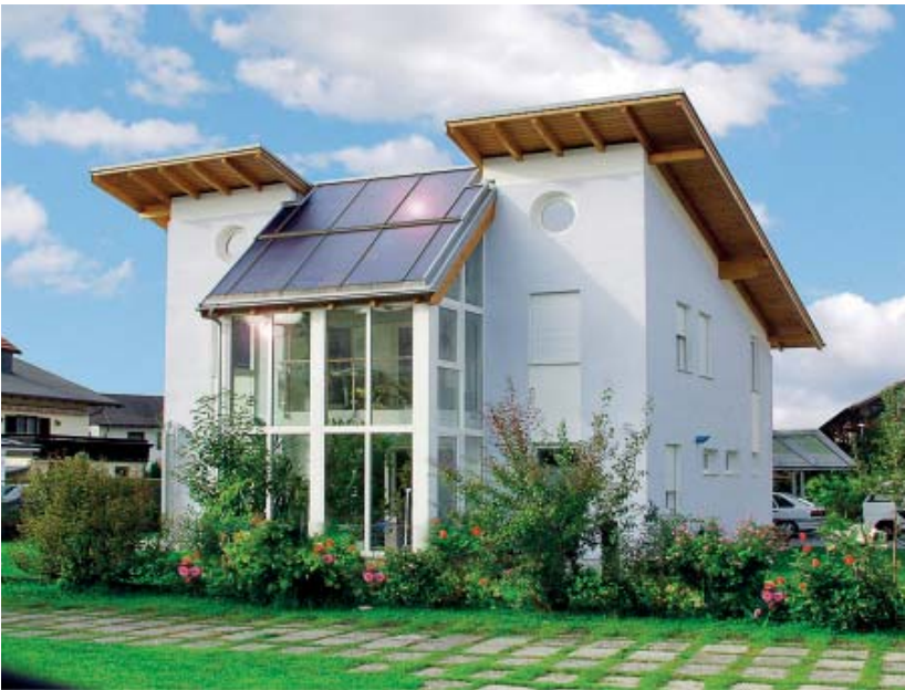
Eksempel på delintegration, som i projekt Ring Søpark i Brædstrup videreudvikles til at udgøre selve tagfladen. Foto: Solarcap.
