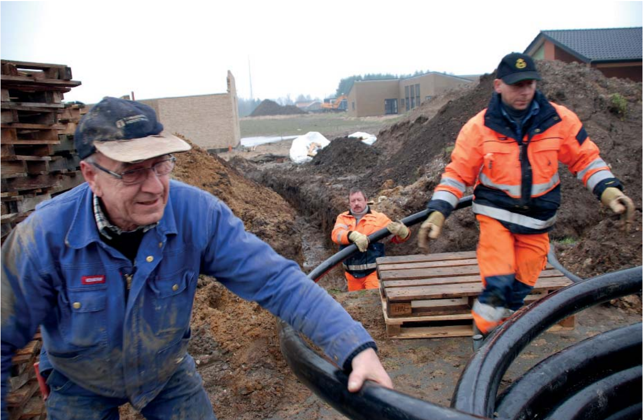
Niels Nielsen og hans to kolleger fra Tjærborg Industri er her i gang med det, rørmeden kalder et temmelig voldsomt slid: En stikledning i form af et fleksibelt pexrør skal på plads i en nyudstykning i Jelling. Foto: Flemming L. Rasmussen.
