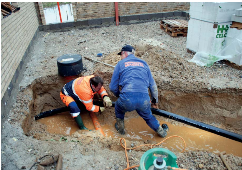
Der skal lægges godt med kræfter i, når de fleksible pexrør skal trækkes og skubbes på plads. Foto: Flemming L. Rasmussen.
