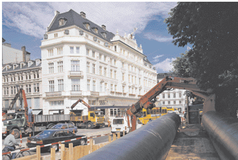
Københavns Energi etablerer fjernkøling i den centrale del af København i området omkring Kongens Nytorv hvor en række større erhvervsjendomme og stormagasiner har erklæret sig villige til at aftage køling. Foto: LOGSTOR.
