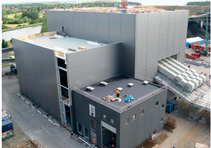
Byggeriet af Fynsværkets halmanlæg er i fuld gang. Til højre ses de fire halm-linjer, der fører halmen fra lager til kedlen. Anlægget kan klare 56 Hesston-halmballer i timen. Foto: Vattenfall.
