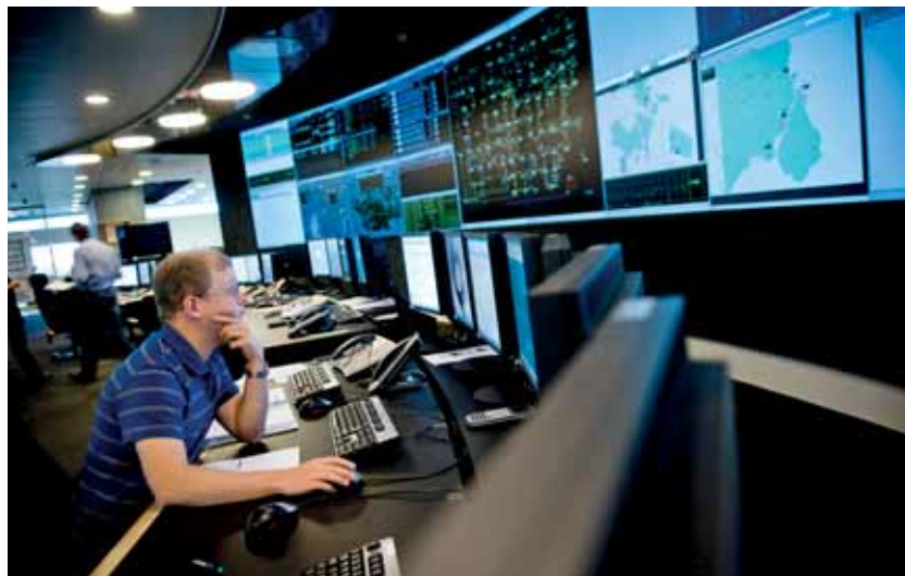
Her fra kontrolrummet har Energinet.dk overblik over energisystemerne i Danmark. Nødforsyningssystemet for naturgas er en afgørende sikkerhedsforanstaltning, i tilfælde af at de normale forsyninger svigter. Foto: Palle Peter Skov.
