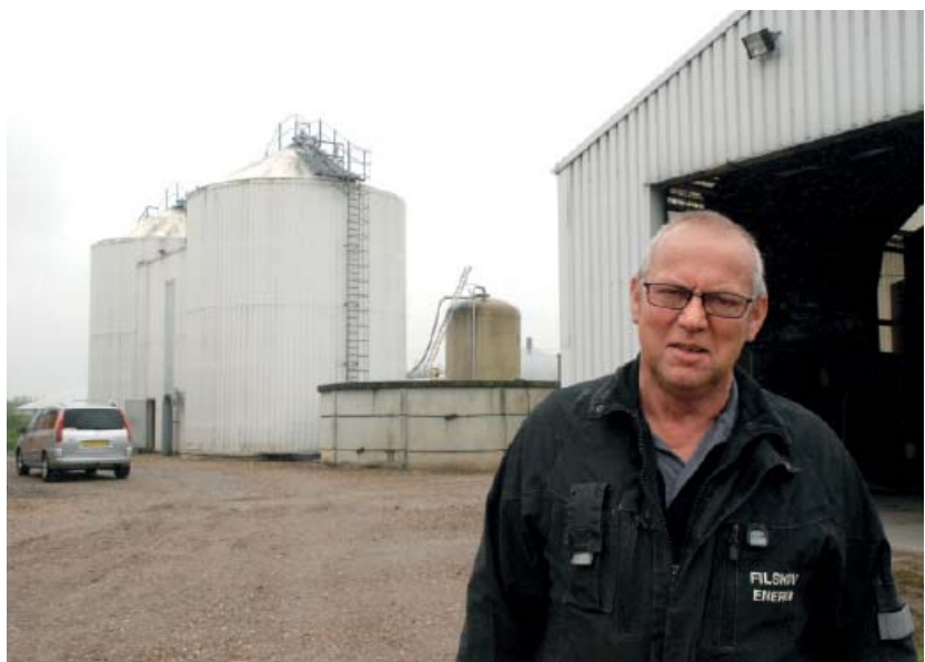
- Det er hverken mere eller mindre vanskeligt at drive et biogasanlæg end så meget andet, mener varmemester Mogens Buhl, Filskov Energiselskab. Foto: Flemming L. Rasmussen.
