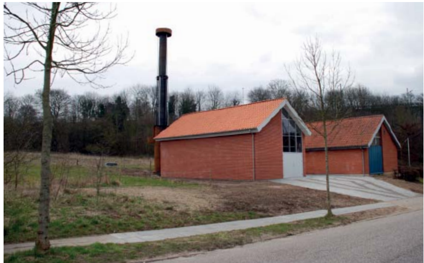
Tre-Fors nye spids- og nødlastcentral i Snoghøj i Fredericia har fået en helt ny type skorsten. Teleskopskorstenen kan udvides fra seks til 17 meter og er kun synlig, når den er i brug. Foto: Flemming L. Rasmussen.
