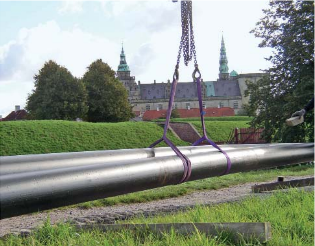
Fjernvarmeledninger (2 x DN 100 mm) uden for Kronborg. Foto: Henning Lambertsen, COWI.
