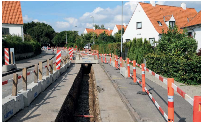
Etablering af fjernvarme i Andelsbyggeföreningen Helsingør.
