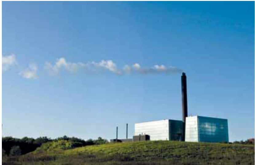
Varme fra forbrændingsanlægget i Lisbjerg indgår i alle de tre scenarier, der analyseres i arbejdet med Klimavarmeplan Århus. Forbrænding af affald har en meget lav CO 2 -udledning.
