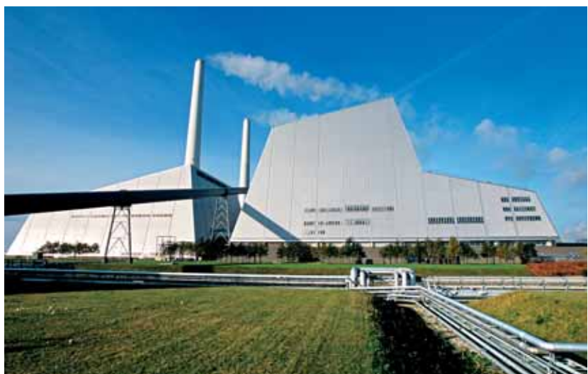
På Avedøreværket udskiftes kul med træpiller, og det er en væsentlig del af forklaringen på, at københavnere kan se frem til mere miljøvenlig energi i fremtiden. Foto: Jørgen Schytte.
