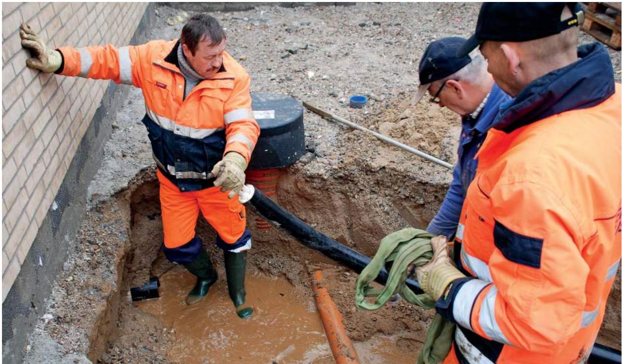
Der er generelt en god miljøeffekt i at droppe elvarmen, det individuelle oliefyret eller gasfyret og i stedet rulle stikledningen på plads og blive tilsluttet fjernvarmen. Det viser Dansk Fjernvarmes beregninger af miljøeffekter. Foto: Flemming L. Rasmussen.
