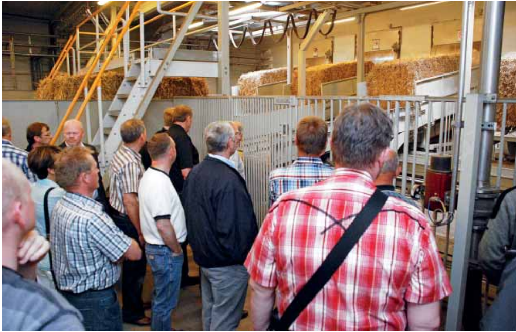
Halmlageret rummer cirka 2.300 baller. Det automatiserede lager sørger selv for at lede halmballerne ind på et af de fire transportbånd, der fører ind til kedlen. Foto: Flemming L. Rasmussen.
