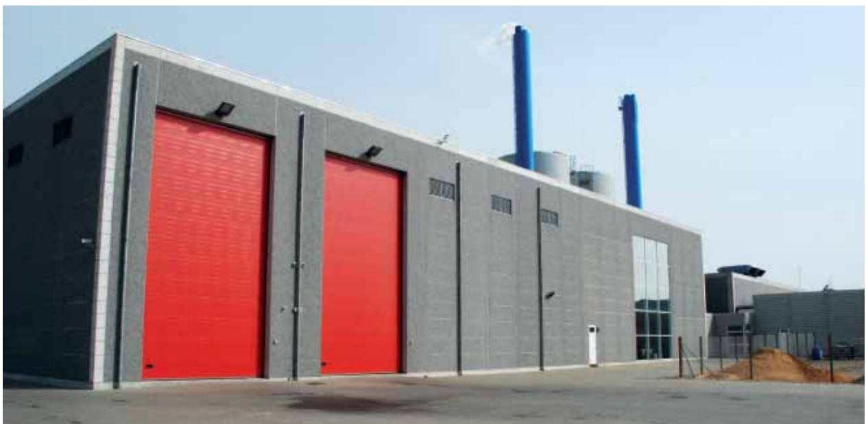
Lem Varmeværk fik i 2007 opført en tilbygning, der indtil videre huser en 5 MW flis kedel. Der er dog plads til, at der kan indsættes endnu en kedel, hvis det skulle blive aktuelt. Foto: Flemming L. Rasmussen.
