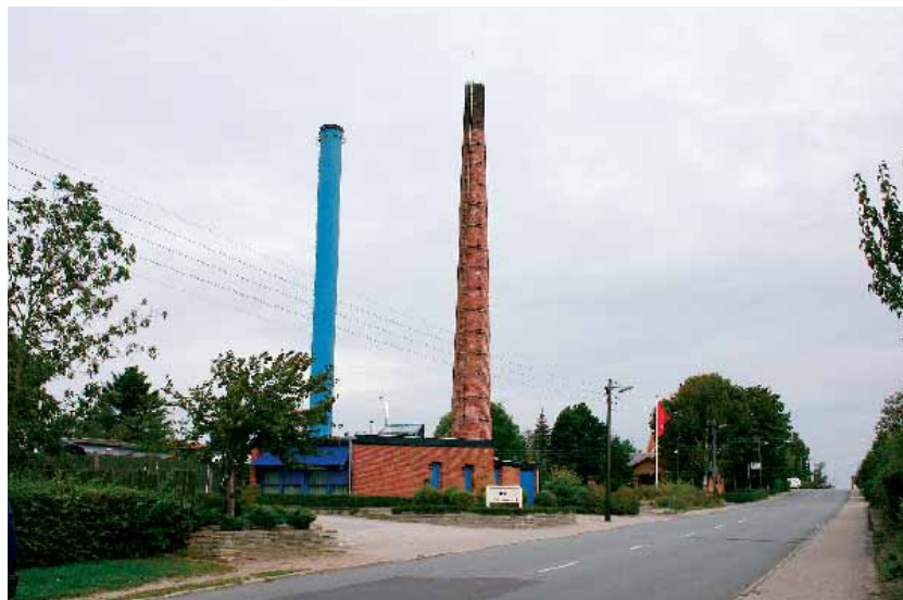
Borup Varmeværk regnede ud, hvad de selv kunne producere deres varme til. Det resulterede i en ny aftale med det halmvarmeværk, der leverer 97 procent af varmeværkets varme. Nu er prisen fast frem til 2011.
