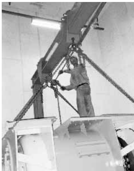
Her bliver den specialkonstruerede "galge" brugt til at løfte en af de 15-tons tunge generatorer fra Brønderslev Kraftvarmeværk.
