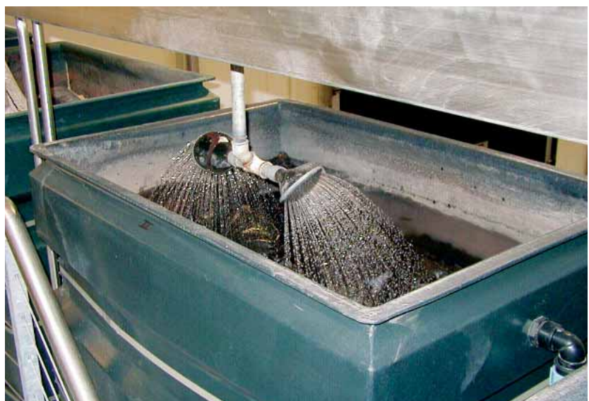
Kondensatet fra flisfyringen renses og genanvendes som spædevand. Første trin er at lade kondensatet løbe gennem et kar med hølvspåner.
