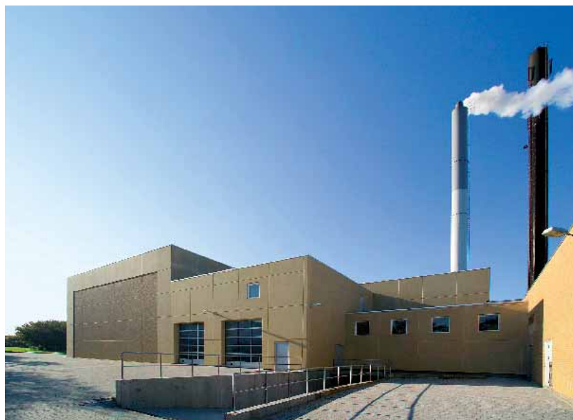
Lemvig Varmeværks nye flisfyrede anlæg anvender årligt 24-25.000 ton flis, som importeres fra de baltiske lande. Foto: Morten Nielsen
