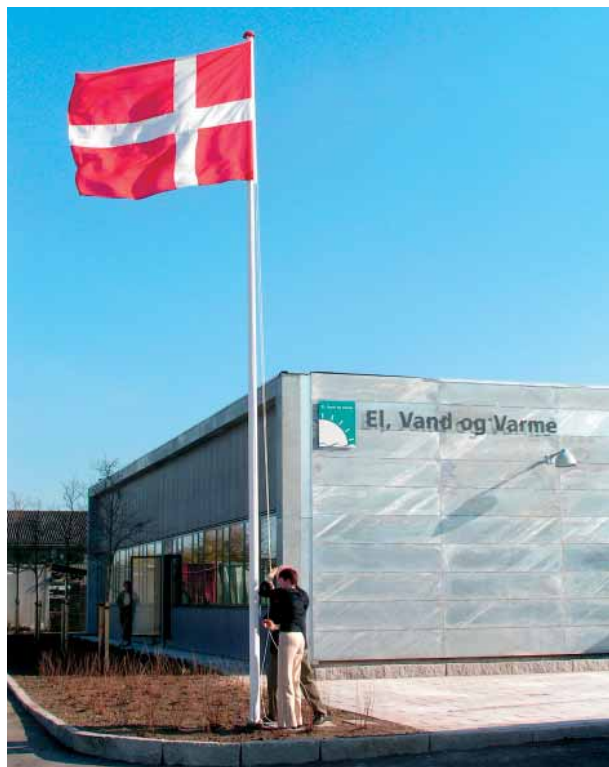
Flaget foran Hillerød Kommunes afdeling for el, vand og varme kan hejses og forsyningen kan med tilfredshed notere sig, at 100 forbrugere er konverteret fra el- til fjernvarme.
