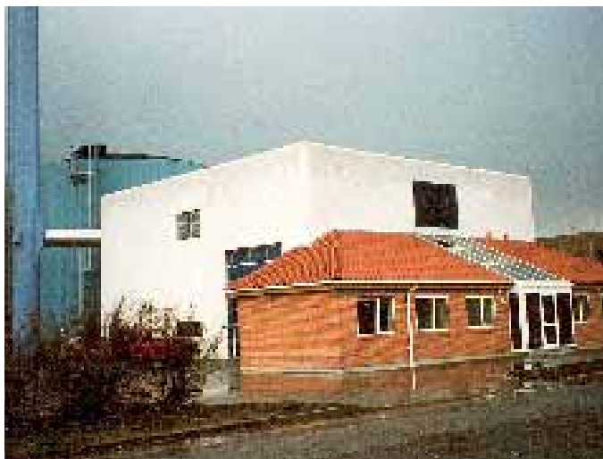
Augustenborg Fjernvarme har 50 års jubilæum den 23. februar 2005.
