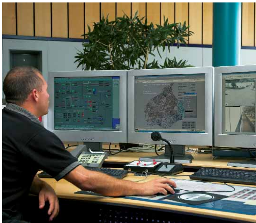
Dynamisk netoversigt er en del af SRO-systemet hos Frederiksberg Forsyning.
