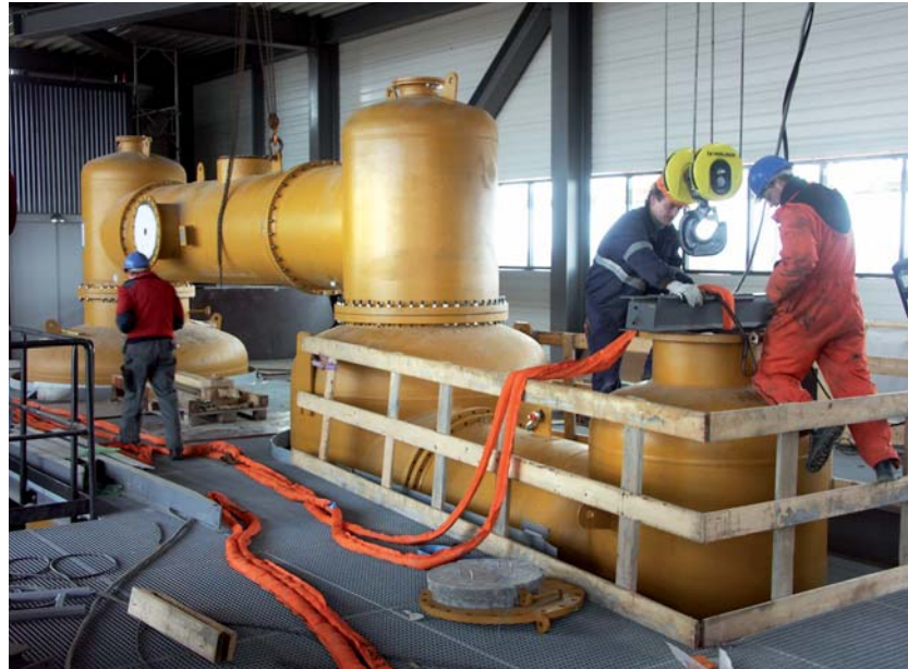
Forgasseren rejser sig i cirka 30 meters højde, hvor toppen her ses. Forgasseren er konstrueret i et materiale, der skifter farve, når gassen på indersiden når den rette temperatur. Foto: Flemming Rasmussen.
