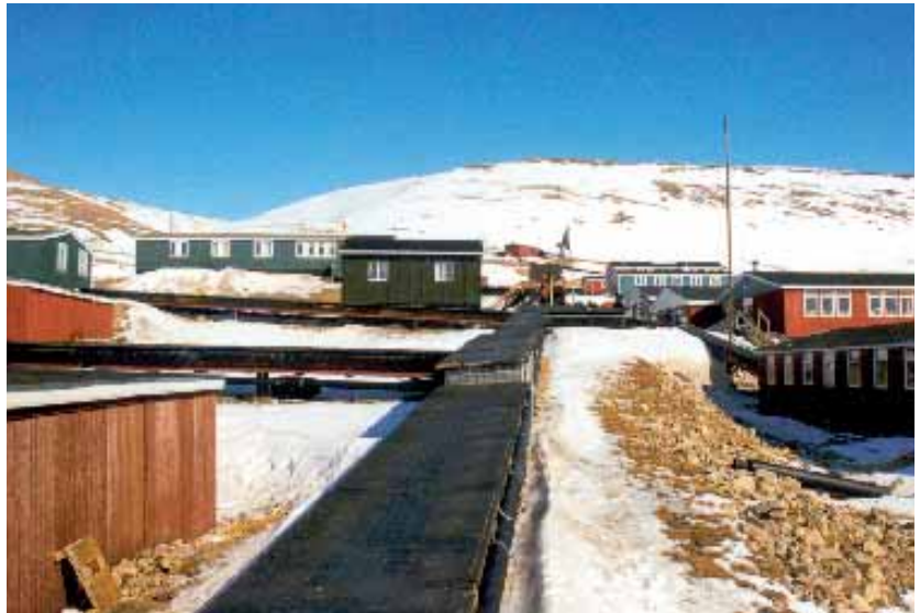
Fjernvarmerørene ligger i kanalkasser, der om vinteren bruges som fortovej.
