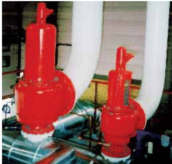
Sikkerhedsventiler kan nu også afprøves, mens de sidder i drift.
