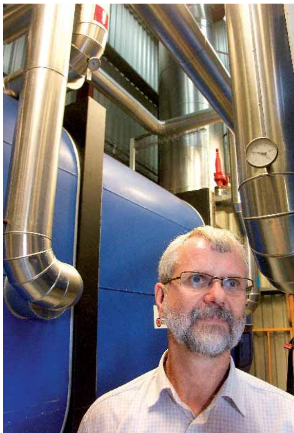
Videbæk Energiforsyning går over til kondenserende drift, så røggassen kan udnyttes. Det sker blandt andet ved at indsætte en ekstra kedel under den eksisterende, der her ses bag selskabets direktør, Ib Melsen. Foto: Flemming Rasmussen.
