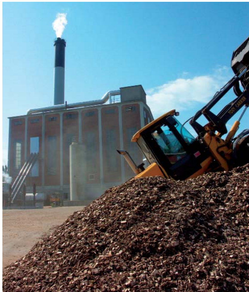
Lastbilerne med træflis er begyndt at besøge Dalum Papir med korte intervaller. Papirfabrikken har ombygget sit kraftværk for i alt 64 millioner kroner så der nu bruges biomasse og overskudsvarmen kan bruges i Odenses fjernvarmenet. Foto: Flemming Rasmussen.
