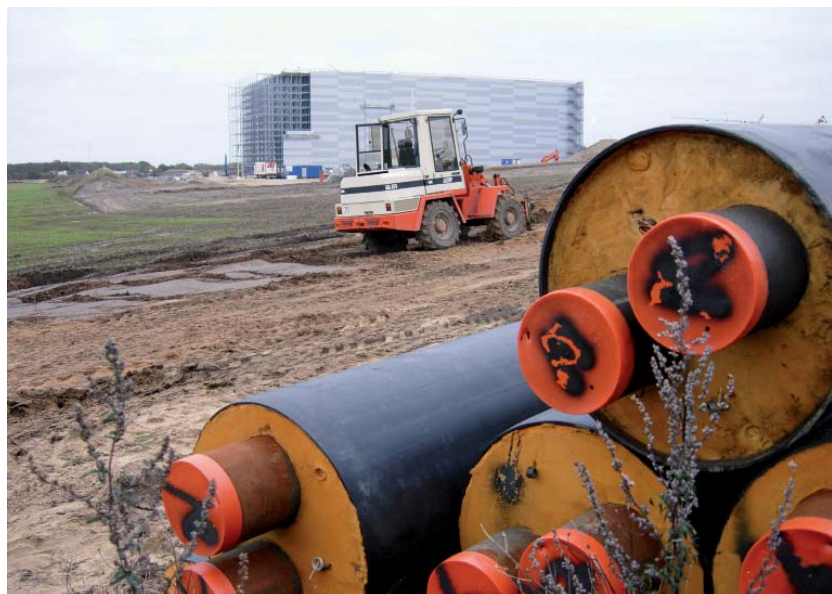
Jysk's centrallager i Uldum bliver med sine 70.000 m 2 Nordens største lagerbygning. Lageret skal forsynes med fjernvarme fra Uldum Fjernvarme, der er godt i gang med etableringen af den 2,1 km. lange fjernvarmeledning til det nye erhvervsområde. Foto: Lars Rossen.
