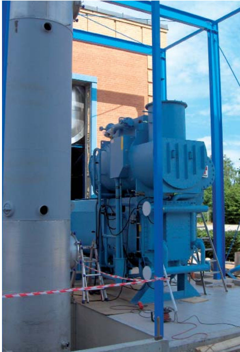
Med stigende gaspriser og stabile el-priser har målet for Bjerringbro Varmeværk været at få mest mulig varme ved brug af mindst mulig energi. Det er lykkedes med installationen af en absorptionsvarmepumpe på den ene af værkets fire gasmotorer. Foto: Bjarne Christensen.
