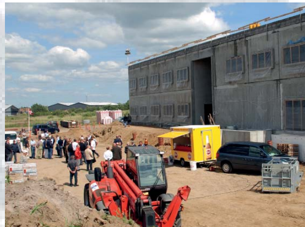
Arbejdet skrider planmæssigt frem, og der har været rejsegilde på den nye tilbygning til Fjernvarmens Hus. Foto: Flemming Linnebjerg Rasmussen.
